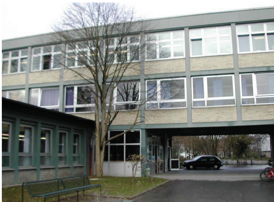
Abb. 8 : Willy-Brandt-Gesamtschule, Abt. 8 – 10 (vor der Sanierung)
