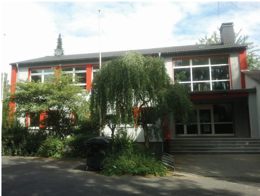
Abb. 15: Jugendheim Balu (nach der Sanierung)
