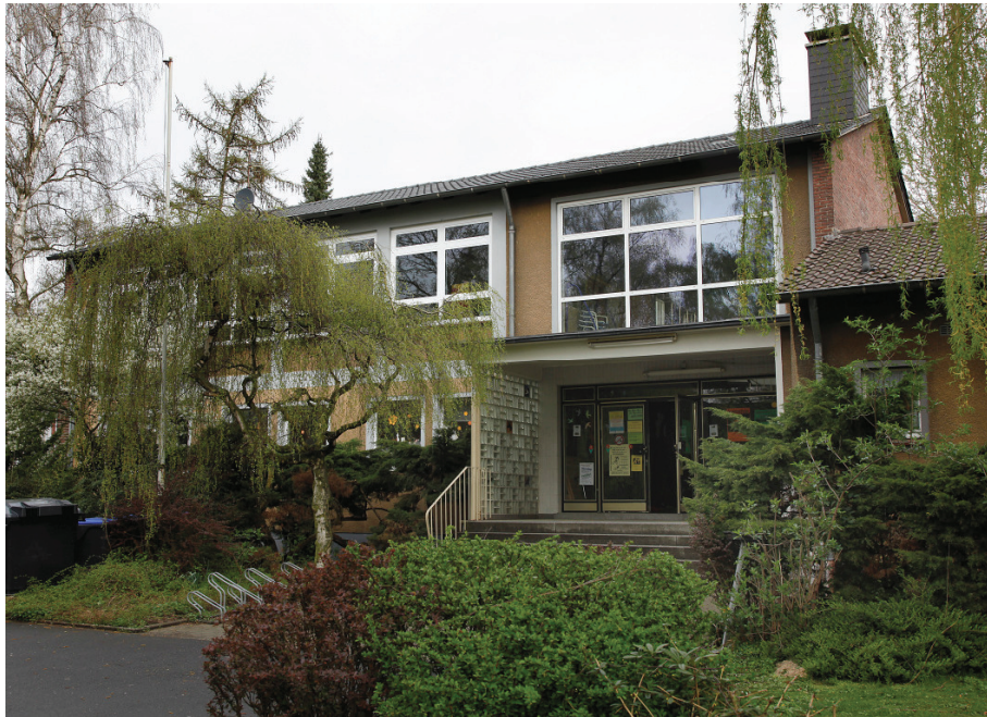
Abb. 14: Jugendheim Balu (vor der Sanierung)
